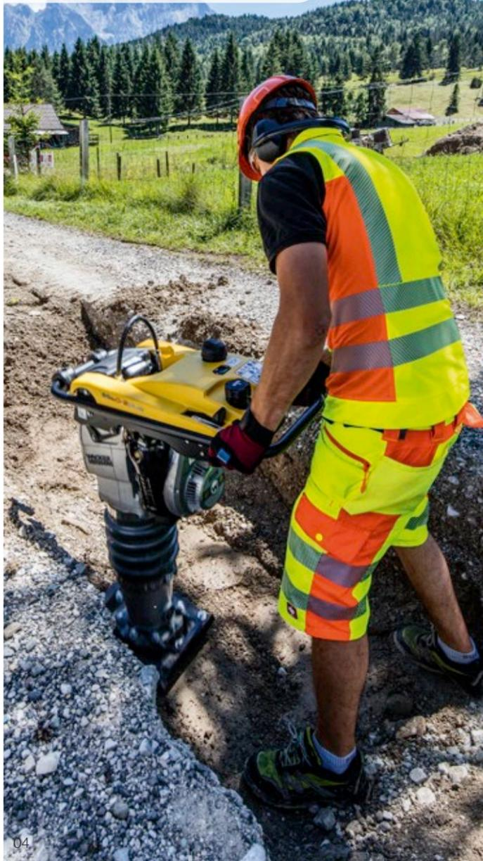
Verdichtung an Rohren – zentimetergenau mit dem schmalen Stampfuß des BS30.
