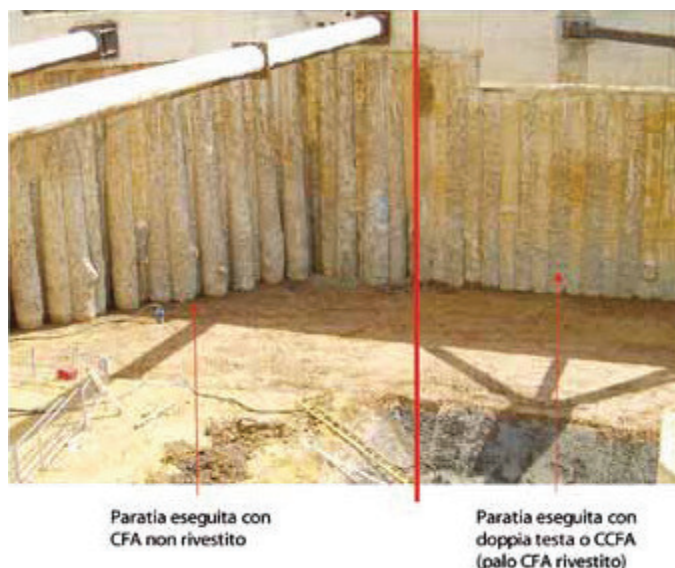
Figura 10. Pali secanti in CFA contigui a pali in CCFA; si notino le deviazioni dei pali in CFA e la perfetta linearità e tenuta di quelli in CCFA
