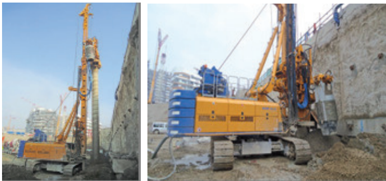
Figura 7. BTM 400K su BG30 Premium Line per il progetto di CityLife a Milano (FONDAMENTA)
