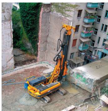
Figura 4. Perforazione FoW a doppia testa in ambiente urbano
