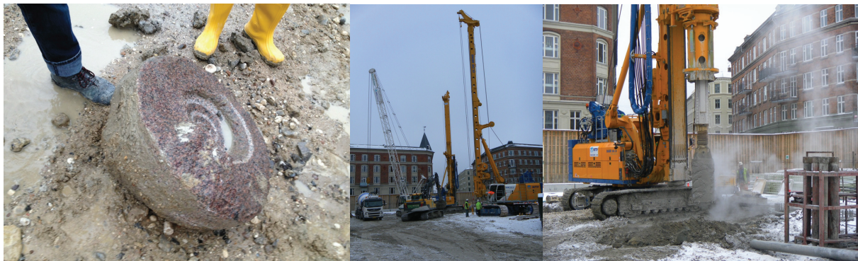
Figura 14. Metro Copenaghen - si notino: 1. il materiale lapideo ad elevata resistenza opportunamente carotato, 2. Le macchine in batteria al lavoro e 3. La fase di perforazione di alleggerimento
