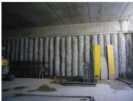
Figura 2. Sottopasso della Stazione di Mestre (MANTOVANI)
