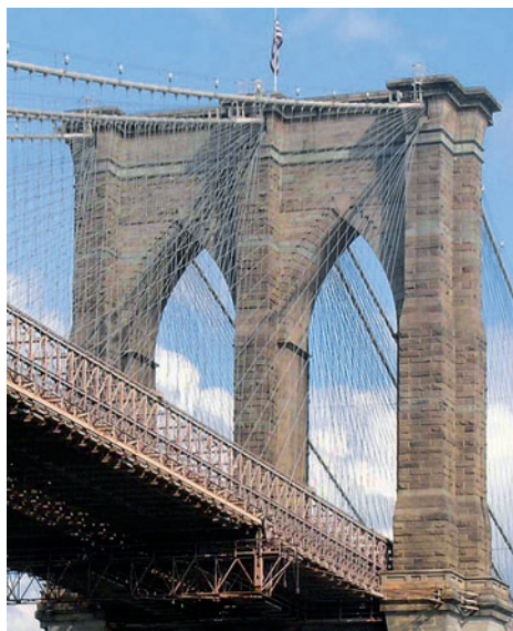
Particolare del ponte di Brooklyn a New York (1877).
