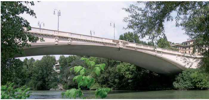
Ponte Risorgimento a Roma, di François Hennebique (1910), una delle prime strutture in cemento armato realizzate in Italia.
