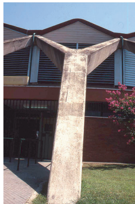
Pilastro in cemento armato.
