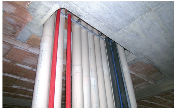
Tubazioni in PVC in un edificio in costruzione.
