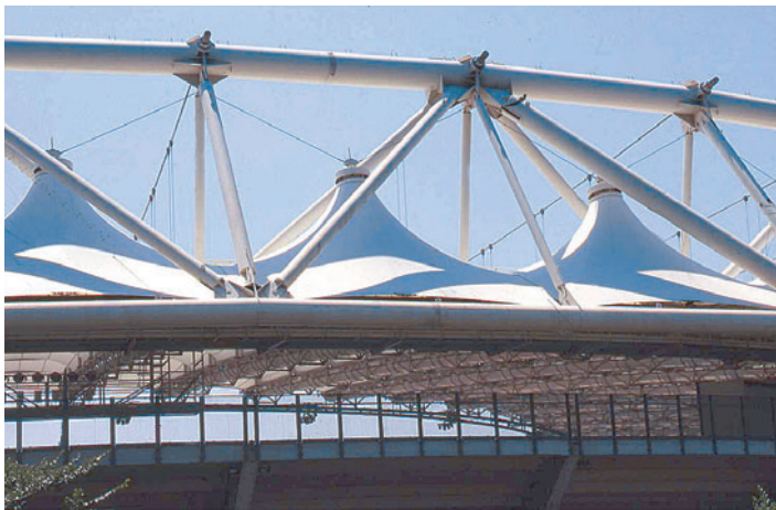
Copertura dello Stadio Olimpico di Roma.
