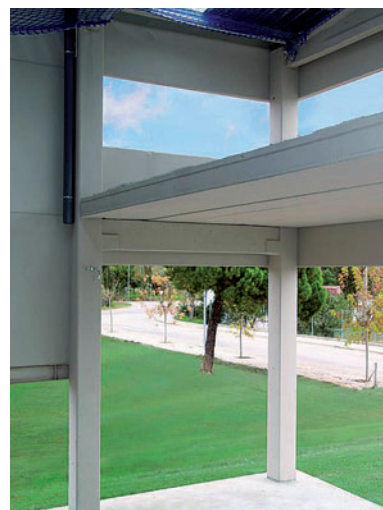
Travi e pilastri prefabbricati.
