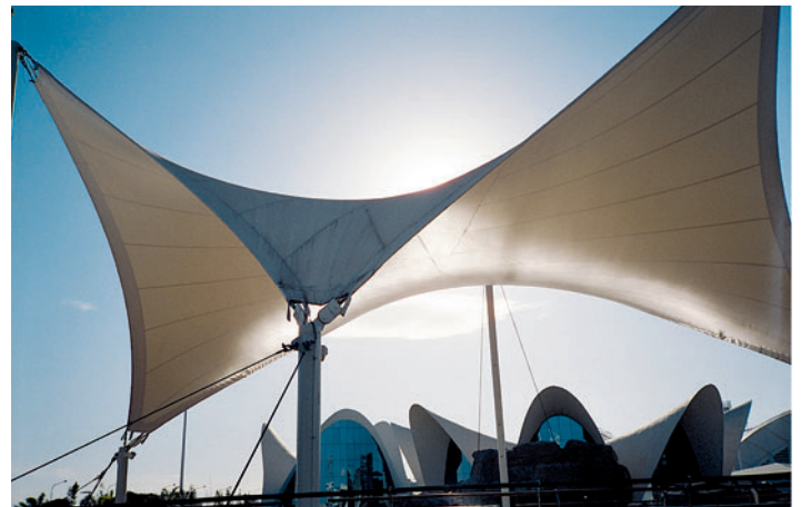
Tensostrutture in materiale sintetico (Città delle Scienze e delle Arti a Valencia).
