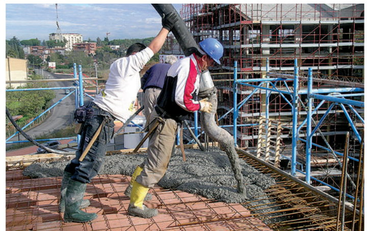
Solaio durante il getto.
