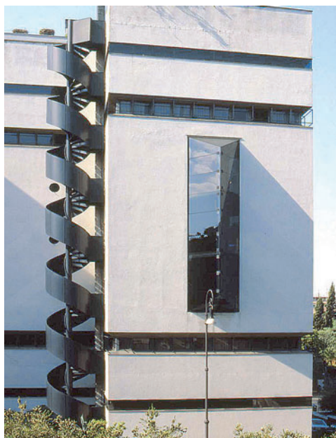
Scala di sicurezza.
