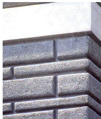
Particolare di parete in bugnato.
