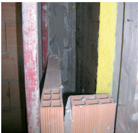
Muro perimetrale coibentato.
