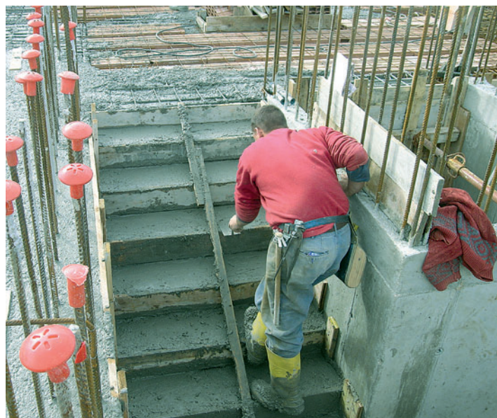
Costruzione di una scala in cemento armato.
