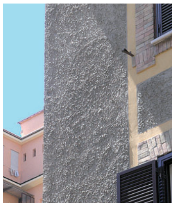
Esempio di intonaco lavorato.
