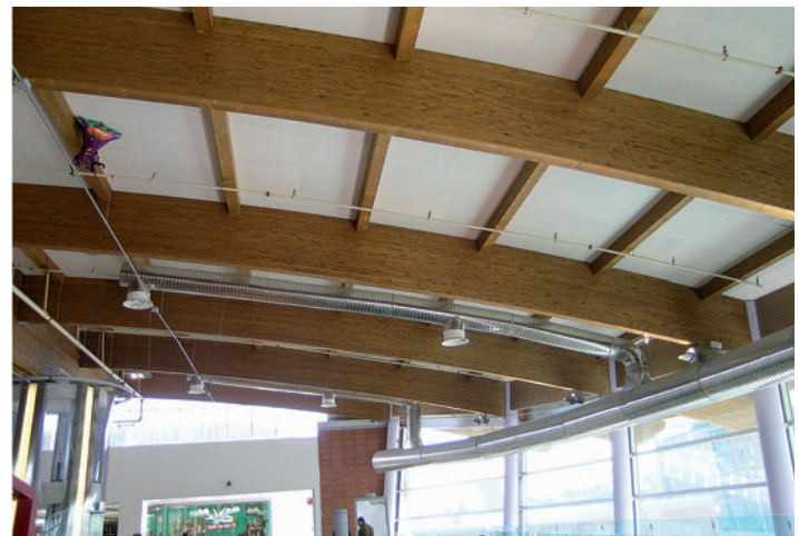
Struttura in legno lamellare.
