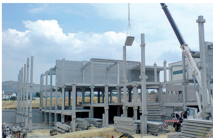
Edificio in costruzione con elementi prefabbricati.
