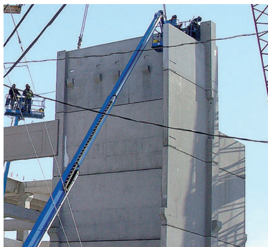
Edificio in costruzione con elementi prefabbricati.
