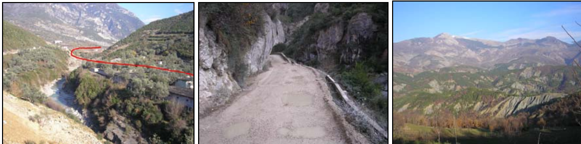
Fig. Peisazhi pergjate gjurmes se rruges ne skajin perendimor (foto majtas); ne kanionin e Tujanit (foto e mesit); dhe ne pjesen lindore (foto djathtas) te zones se projektit.
