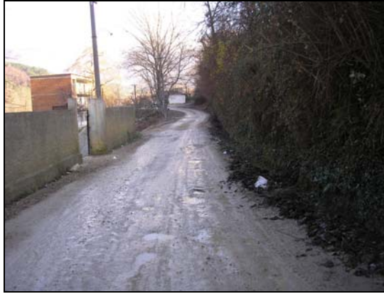
Fig. Rruga egzistuese, ne fshatin Zall Dajt, ne te cilen kalon gjurma e rruges se projektur.
