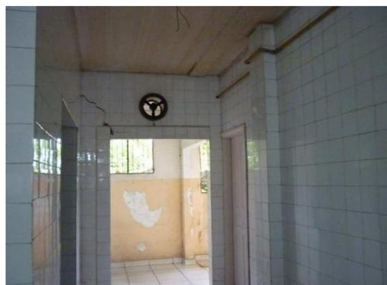
Imagem 16: Parede com trinca e forro com placas caindo
