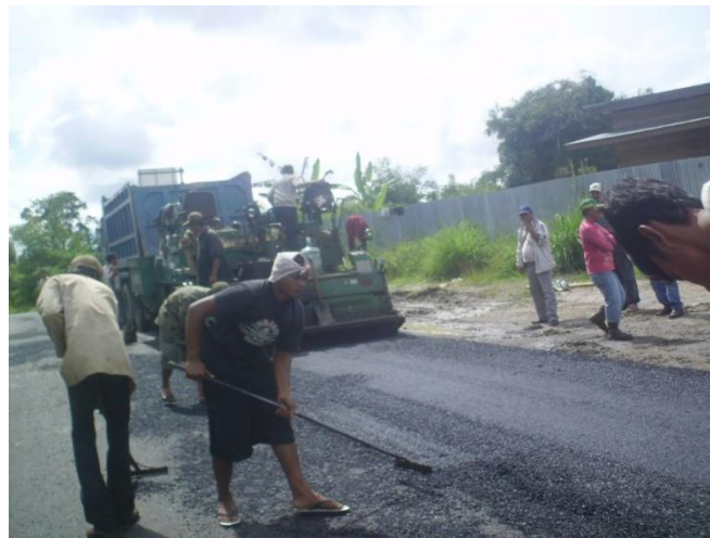
Gambar 3. Pengaspalan jalan yang ada lubangnya ( tambal sulam )
