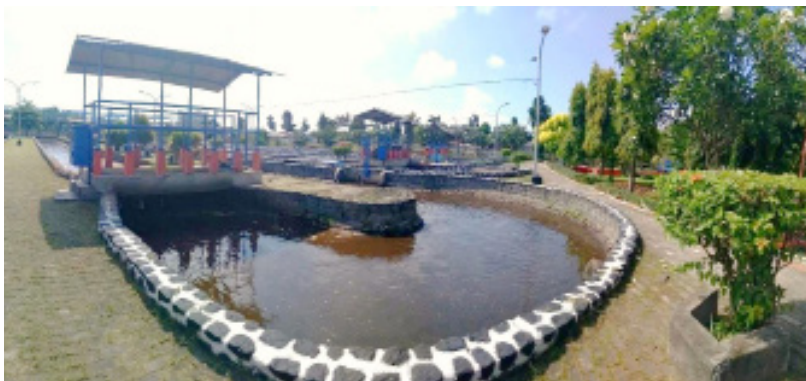
Gambar 6-7 Oxidation Ditch sebagai Unit Stabilisasi Cairan di IPLT Keputih, Surabaya
