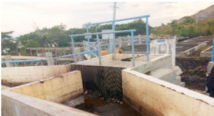
Gambar 6-3 Unit penerimaan dan penyaringan lumpur tinja pada IPLT Gampong Jawa, Banda Aceh
