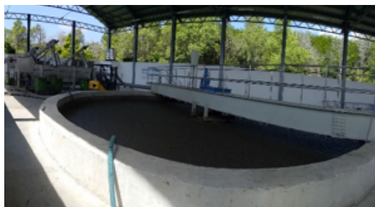
Gambar 6.2 IPLT Suwung memanfaatkan Thickener sebagai unit pemisahan padatan dan cairan
