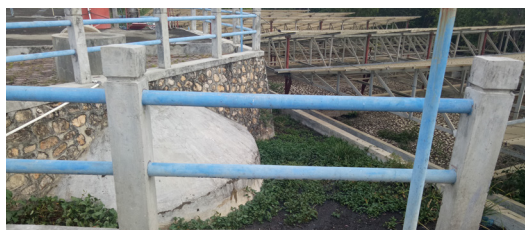
Gambar 6.3 IPLT Gampong Jawa menerapkan Fixed Dome Anaerobic Biodigester untuk memekatkan dan mengolah lumpur
