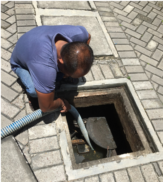
Gambar 2.4 Seorang petugas sedang melakukan penyedotan lumpur tinja dari sebuah tangki septik
