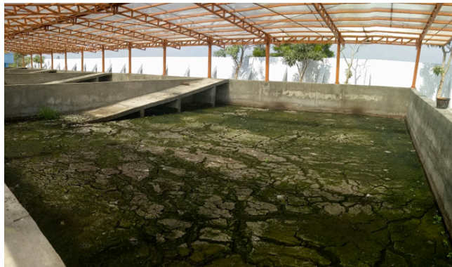
Gambar 6.5 Sludge Separation Chamber (SSC) merupakan salah satu unit pemekatan yang banyak diterapkan di Indonesia
