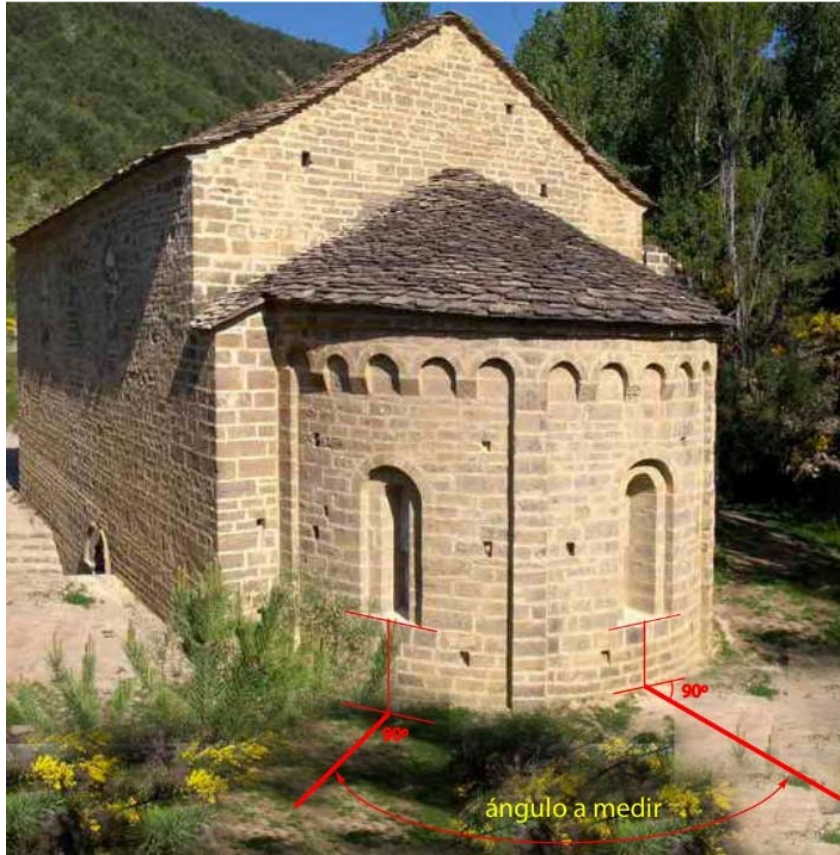
Figura 12: Medición del ángulo de separación entre dos ventanas consecutivas en el exterior de San Adrián de Sasavé
