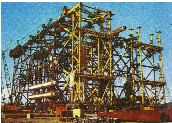
Fig. 7 Piattaforma Enchova Petrobras
