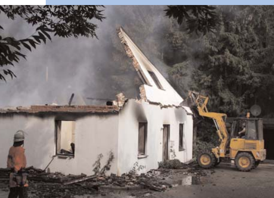
Gegen 10.45 Uhr wird die Giebelwand mit einem Radlader eingestoßen.
