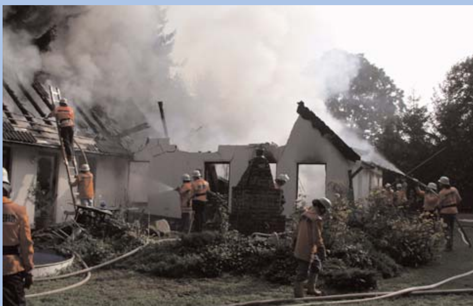
Die Einsatzstelle um ca. 9.40 Uhr: Die rückwärtige Giebelwand des Haupthauses ist bereits eingestürzt. Ein Betreten der Ruine ist noch immer unmöglich, deshalb wird von außen Wasser gegeben.
