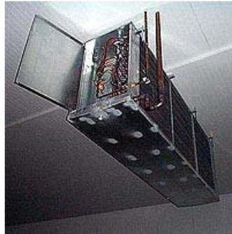
**Figura 9. Evaporador de superficie plana**
