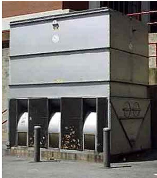
**Figura 6. Condensador enfriado con aire**
