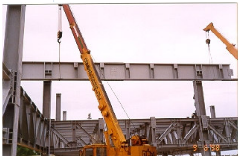
Aeroporto de Natal - Fase de montagem
