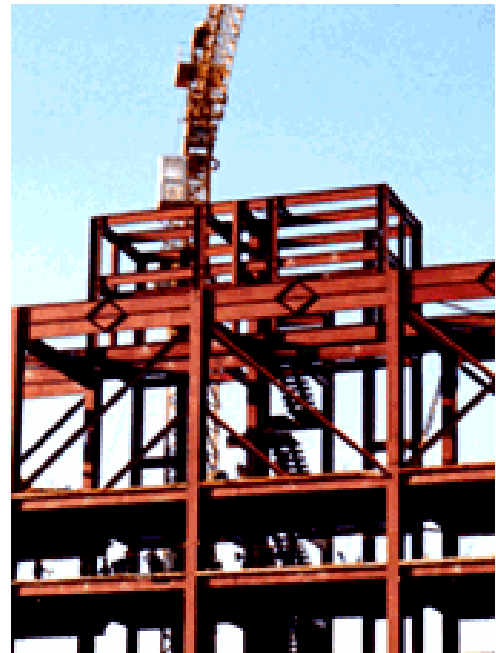
Edifício metálico em construção
