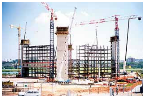
Hotel Caesar Park – em construção
