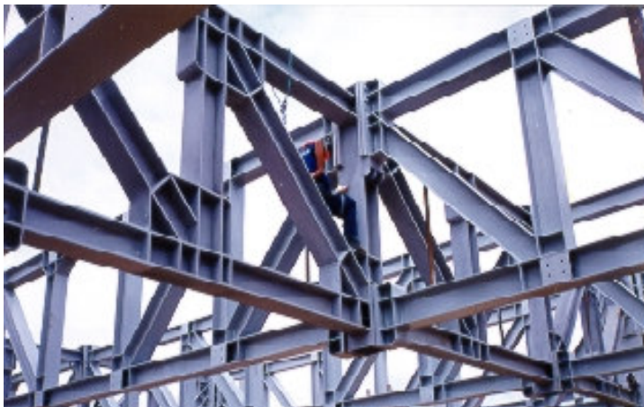
Aeroporto de Natal - Fase de montagem
