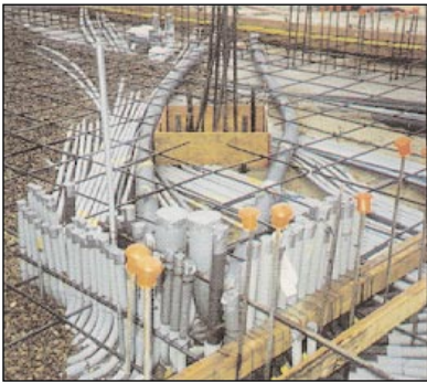
ENT and Rigid PVC Conduit Stub Ups prepared for the pour
